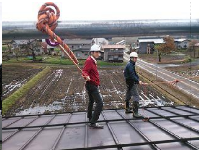
アンカーに安全帯を装着
