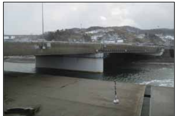
図-1 対象とした橋梁(新潟県上越市)
