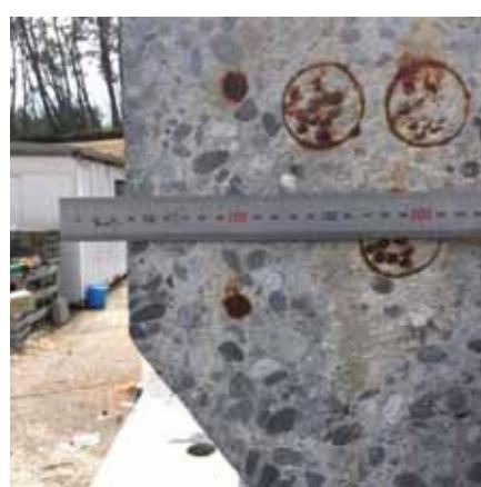
写真 3-6 ブロック 1 海側下フランジ側面のかぶり深さ
