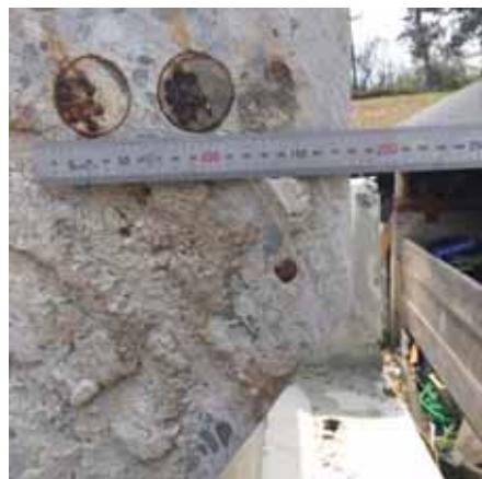
写真 3-5 ブロック 1 山側下フランジ側面のかぶり深さ
