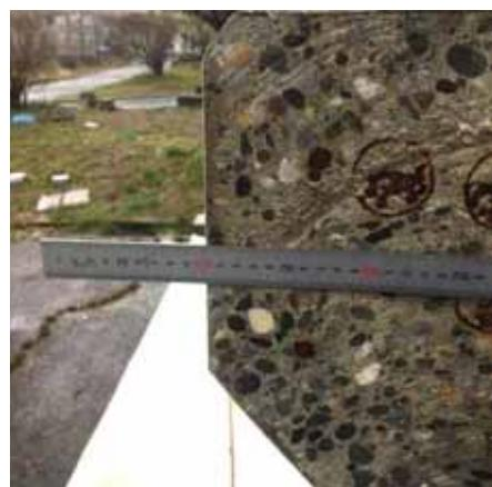
写真 3-8 ブロック 3 海側下フランジ側面のかぶり深さ
