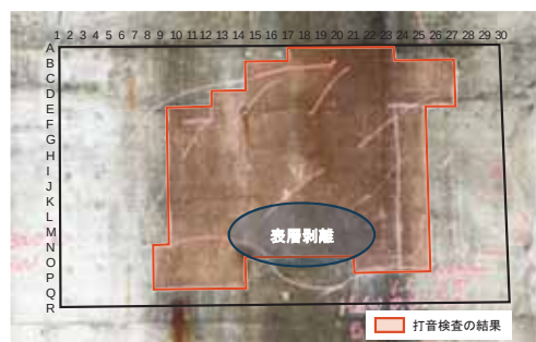
図-16 測定エリアの例（橋台 A エリア 2）
