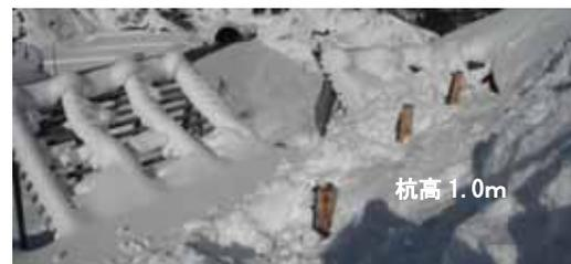
写真 4.3 木杭設置状況（子安トンネル下部）
