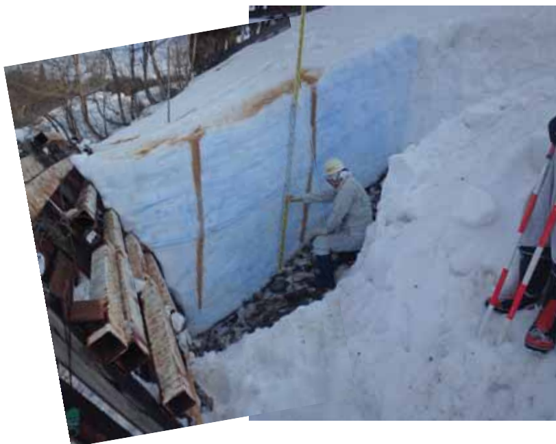
写真2 木杭未設置予防柵斜面
