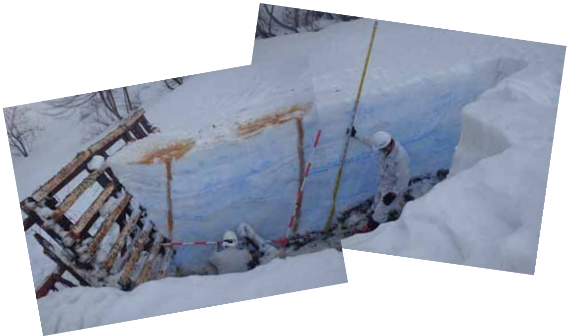
写真1 木杭設置予防柵斜面（杭高0.5m）
