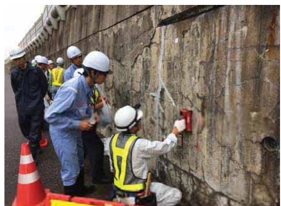
写真-4 はつり前の鉄筋探査状況
