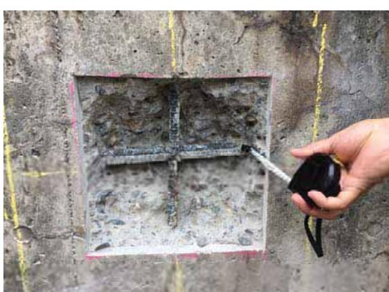
写真-5 翼壁部はつり状況
