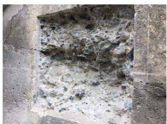
写真-6 擁壁部はつり状況
