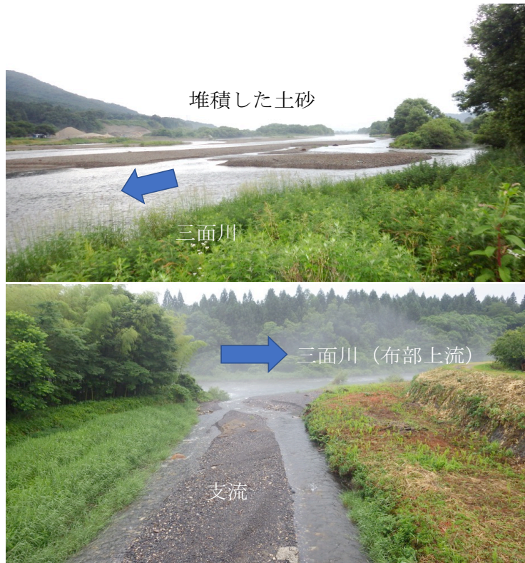
写真-1 支流からの土砂供給（上）及び三面川（本川）における土砂堆積の状況（下）
