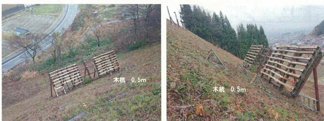
写真 4.3 木杭設置状況（十日町試験地）
