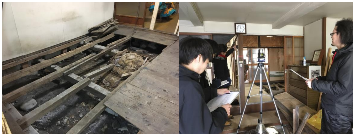
【写真 12・13：長屋の現況調査の様子。写真左：基礎部の損傷は激しく、材料の再利用は難しい判断が下された。写真右：当日見学で参加した職能短期大学校、伊藤研究室の学生に説明を行う清水氏】
