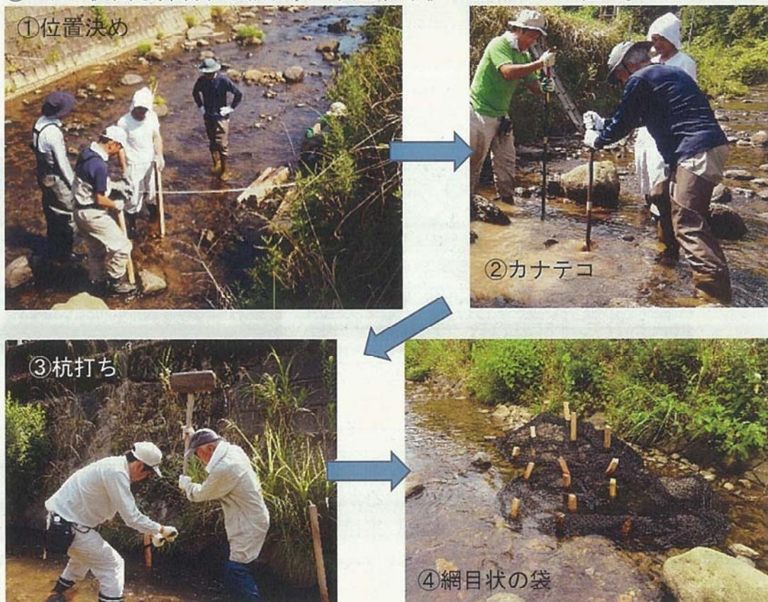
写真-16 バーブ工設置のための事前作業の流れ
