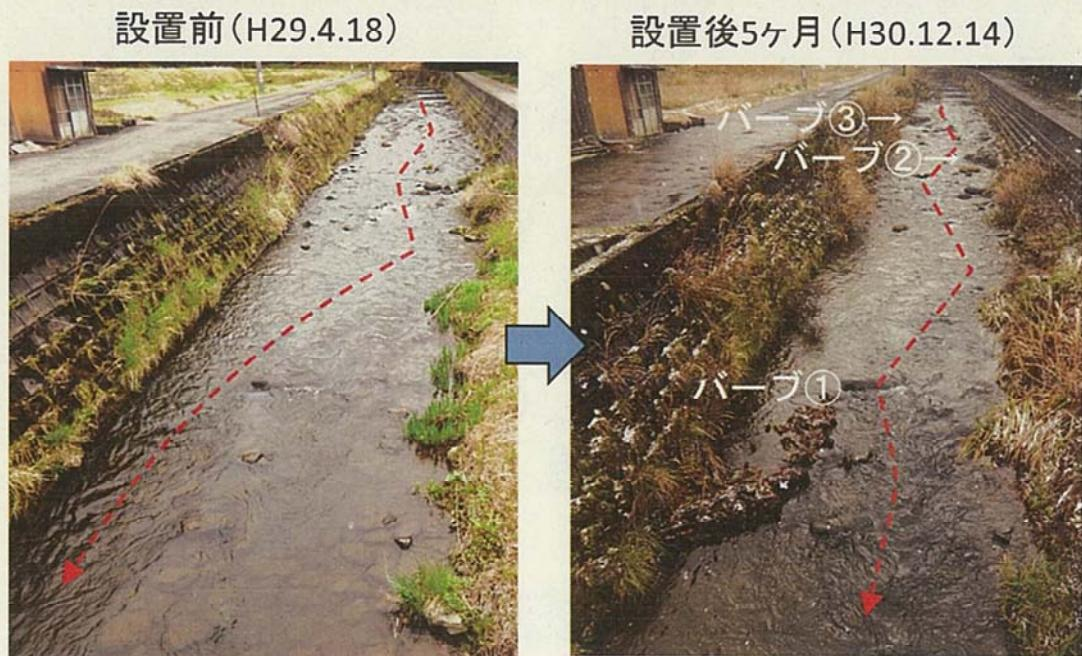
写真-25 バーブ工による流れの変化（設置 5 カ月後 H30. 12. 14）
