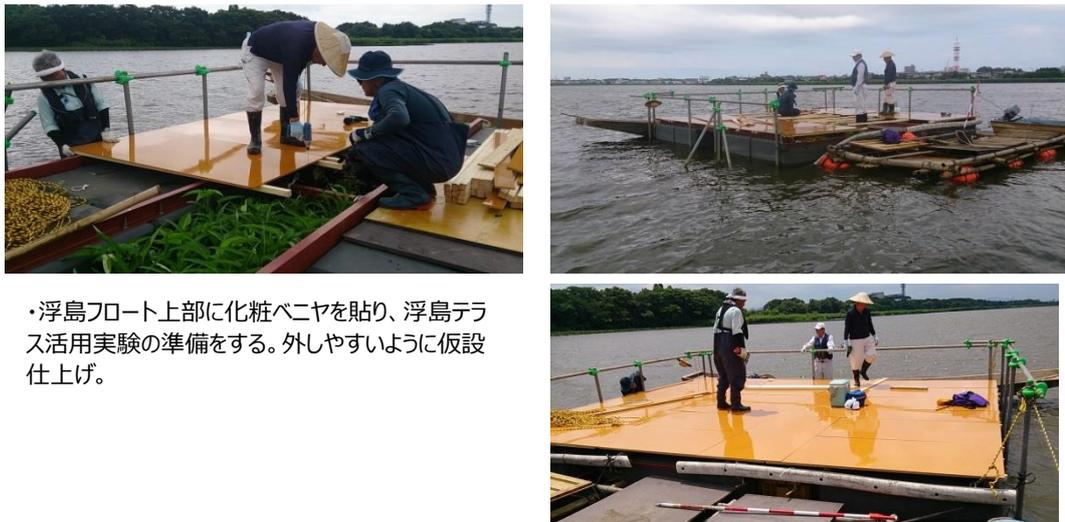
・浮島フロート上部に化粧ベニヤを貼り、浮島テラス活用実験の準備をする。外しやすいように仮設仕上げ。
