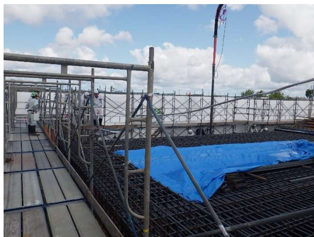
図－9 施工状況把握チェックシートの実習状況
