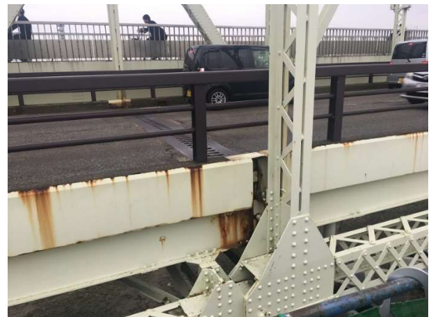
ゲルバー ヒンジ部の構造
