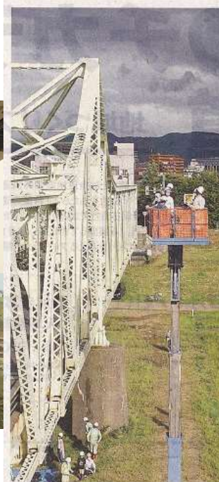
高所作業車に乗り、高さ12mから長生橋を観察する親子ら＝27日、長岡市左近町
