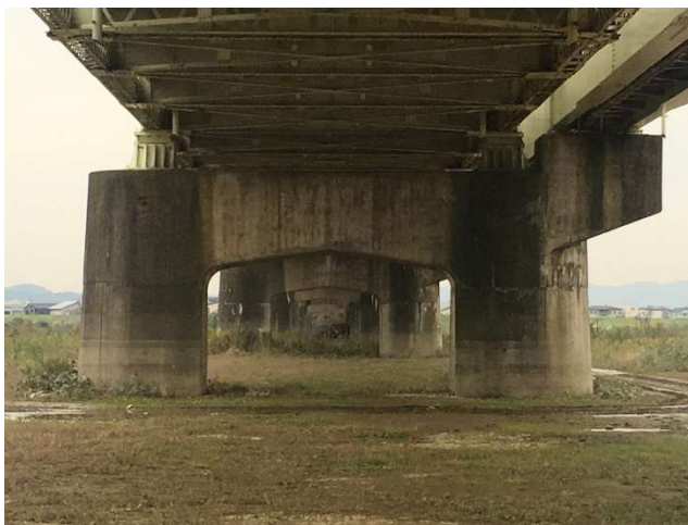
長生橋 下部工(橋脚)
