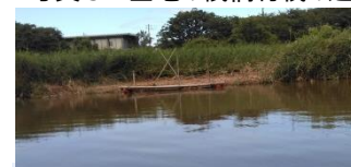
写真 6：北基地の栈橋筏を設置
