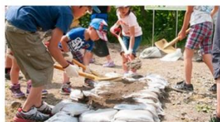
子どもたちでも持てる小さい土嚢袋を使って、土嚢の積み方を習う。水の流れには袋のお尻を向けること、重ねたらよく踏み固めること、間に土を盛ることなど、たくさんのコツを習う。
