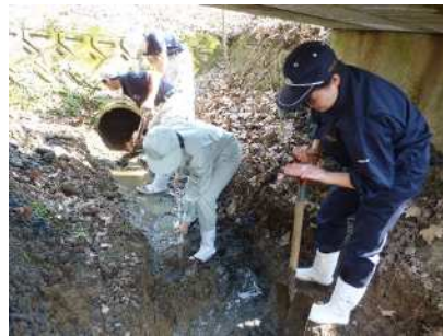
水路整備（泥上げ）
