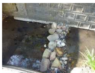
堰の設置実験
