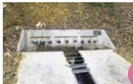
水抜ボーリング工(妙高市猪野山)
