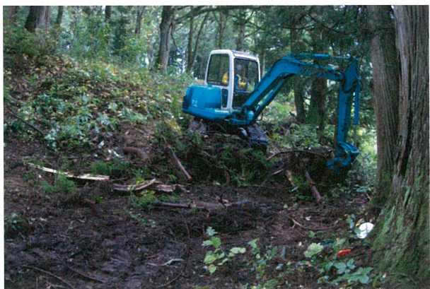
建設機械を使用しての伐根処理、整地作業状況
