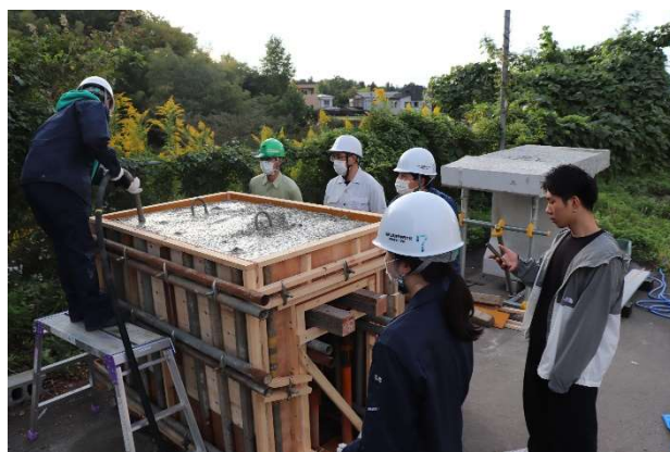
図-4 コンクリート打込み実習
