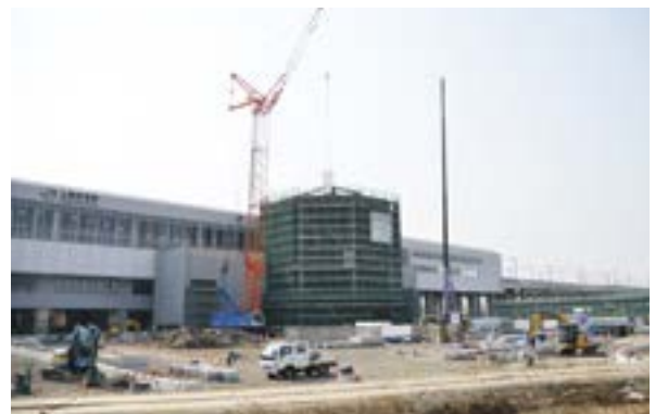
工事が進む上越妙高駅（1月28日撮影）
