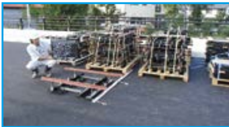
埋設型伸縮継手装置の材料確認
