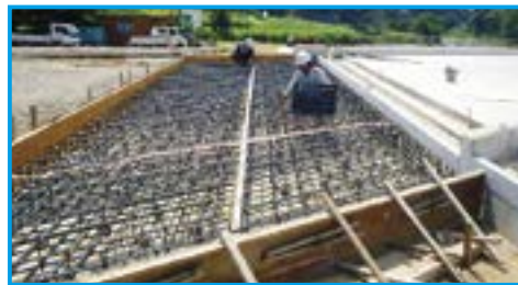
コンクリート打設前（踏掛板配筋）の段階確認
