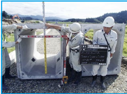
ボックスカルバートの材料確認
