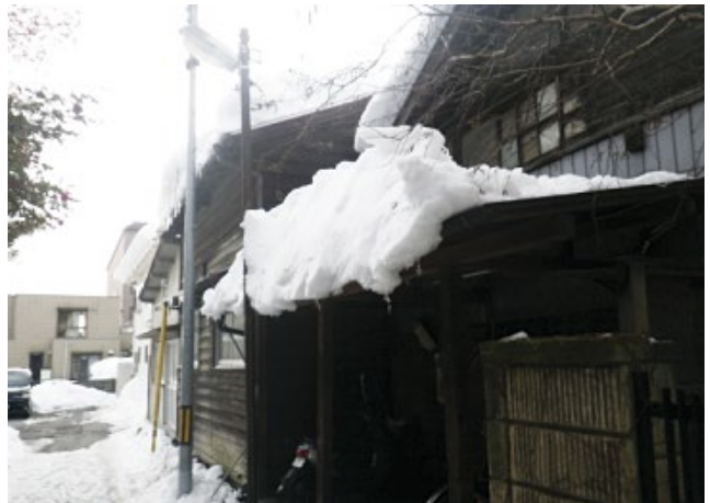
屋根雪が落ちそうな街路 (2月19日甲府市)
