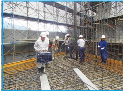
函渠工 コンクリート打設時の施工状況把握
