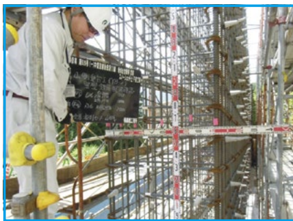
縦壁の配筋確認
