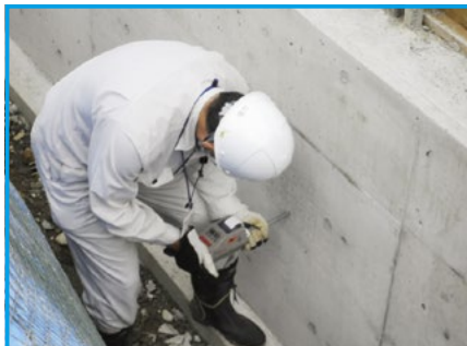
コンクリートの強度確認
