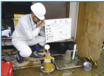
コンクリートの品質試験
