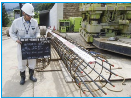
鉄筋かごの材料確認
