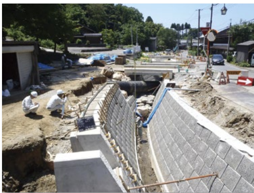
施工管理状況
