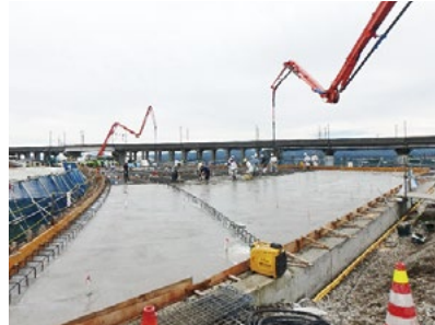
施工状況把握 (コンクリート打設)
