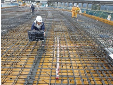
段階確認 (鉄筋組立て完了時)
