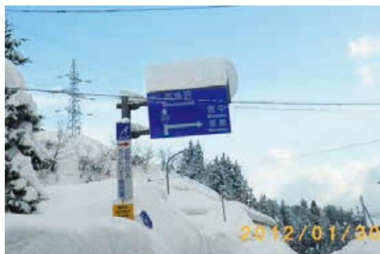
写真2 道路標識への着雪
