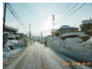
長岡市内の屋根雪(東側に雪庇が張り出し)
