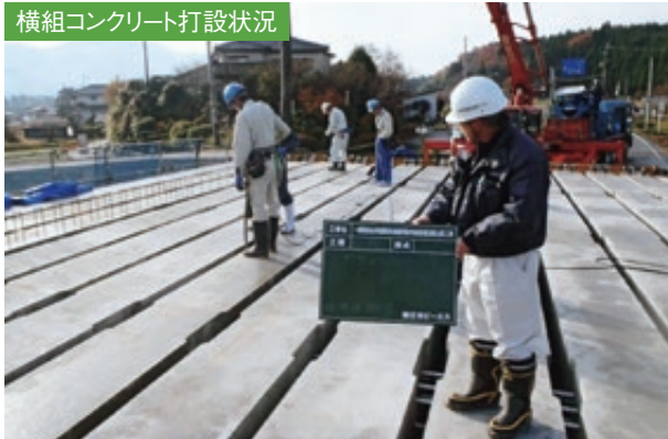
横組コンクリート打設状況
