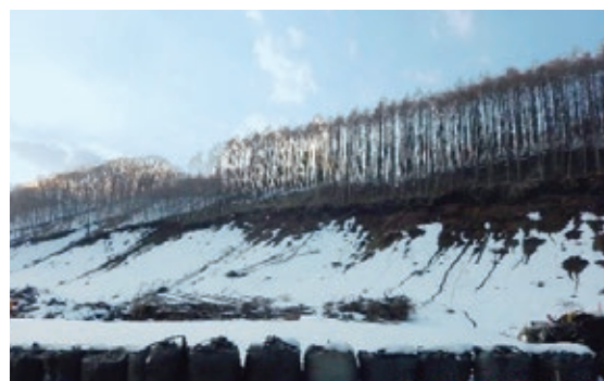
2019年2月 北海道厚真町 9月に土砂災害が発生した斜面
