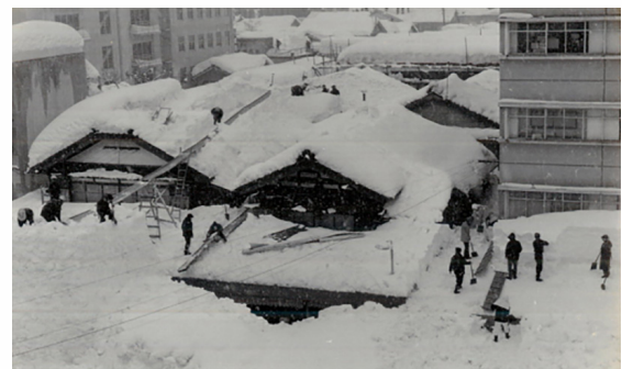
写真1 市民総出の雪処理(長岡市)
