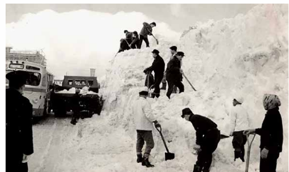
写真2 ダンプによる排雪(長岡市)
