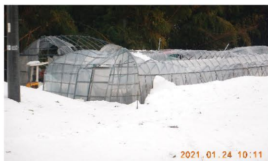
図2 ビニールハウスの倒壊(上越市)
