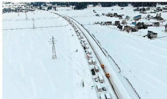
図1 関越道の渋滞(南魚沼市:町田建設撮影)
