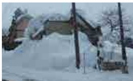
図4 大量の屋根雪による住家の倒壊
