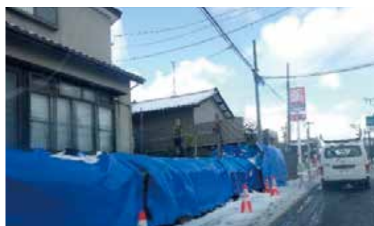
図3 地震による道路の被災と雪の影響 新潟市西区
