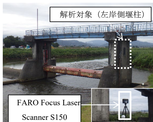
写真-1 計測施設外観
