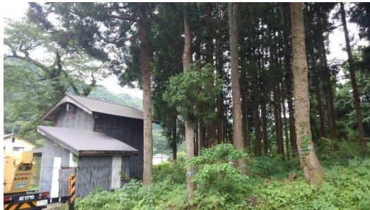
枝打ち作業 前 (高所作業車使用)
