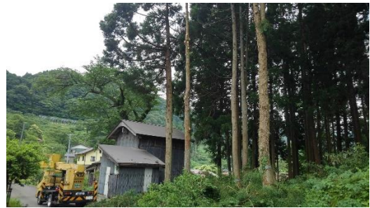
枝打ち作業 後 (高所作業車使用)
