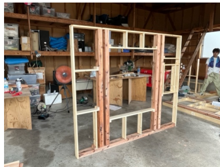
Fig. 27 組み立ての様子
