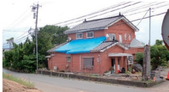
図4 液状化による建物被害 内灘町
