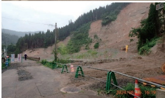
図2 地震による大規模土砂災害 輪島市熊野町
