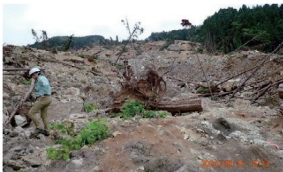
図1 地震による大規模土砂災害 輪島市市ノ瀬町
