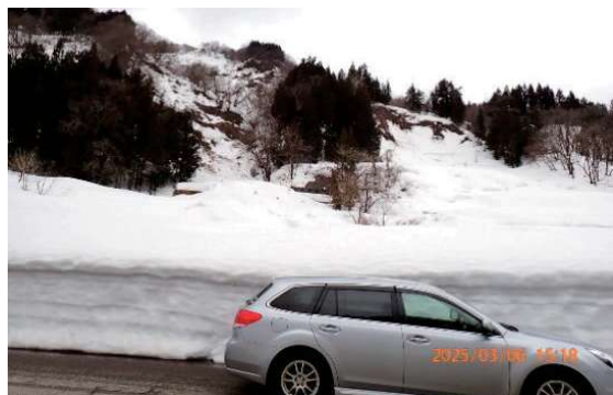
図3 雪崩に埋まった施設(写真中央)
