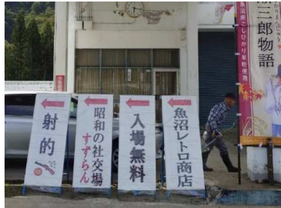
民地内に誘導看板を設置
