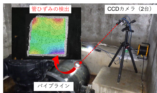
Fig. 2 3次元画像計測状況（マンホール内）
