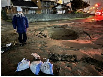
図 1-18 西区ときめきでの噴砂孔
