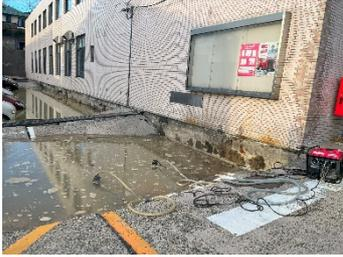
図 1-10 新潟西郵便局での舗装の亀裂・沈下
