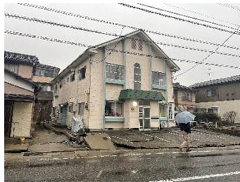
図 1-14 同区寺尾での県道 16 号線に向かった宅地路盤の移動と舗装の圧縮破壊
