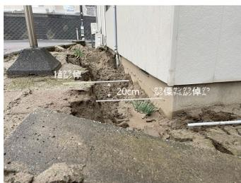
図 1-5 同区寺尾東での低層住宅の基礎部沈下
