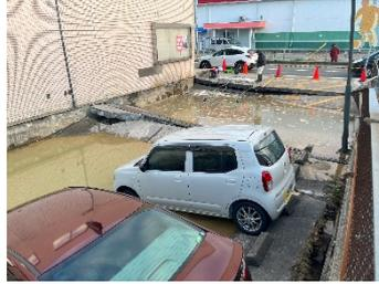
図 1-11 新潟西郵便局での舗装の亀裂・沈下
