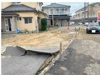
図 1-4 同区寺尾東での舗装部流動
