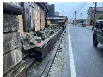
図 1-9 同区寺尾東での県道 16 号に並行する道路沿いでのブロック塀の転倒と顕著な変状のない舗装面
