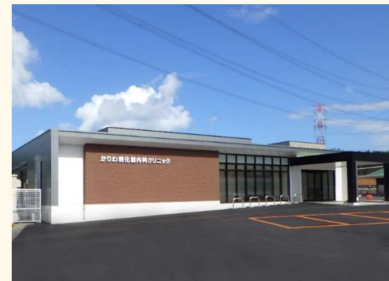
令和4年度 刈羽診療所建設工事 発注支援業務・工事監理業務
