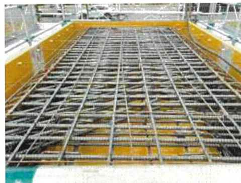
写真1：頂版部配筋状況
