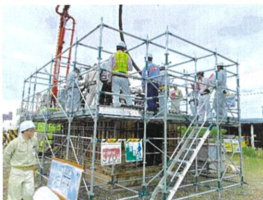
写真2：打設実習の状況
