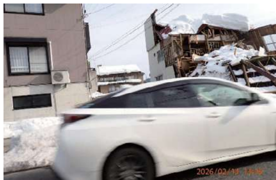
図3 大雪による建物倒壊
