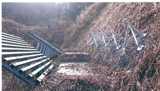
写真 4.1 トライパイル設置状況（小白倉）
