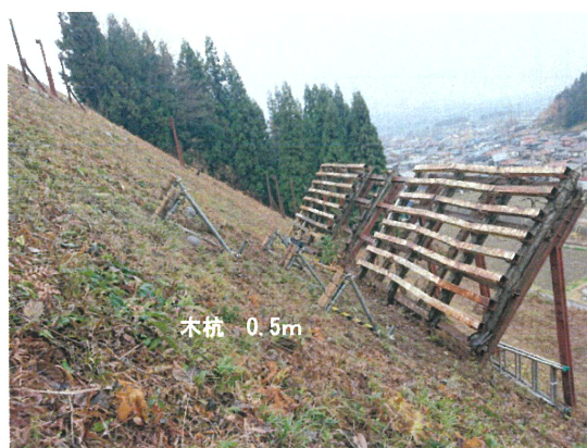
写真 4.3 木杭設置状況（十日町試験地）
