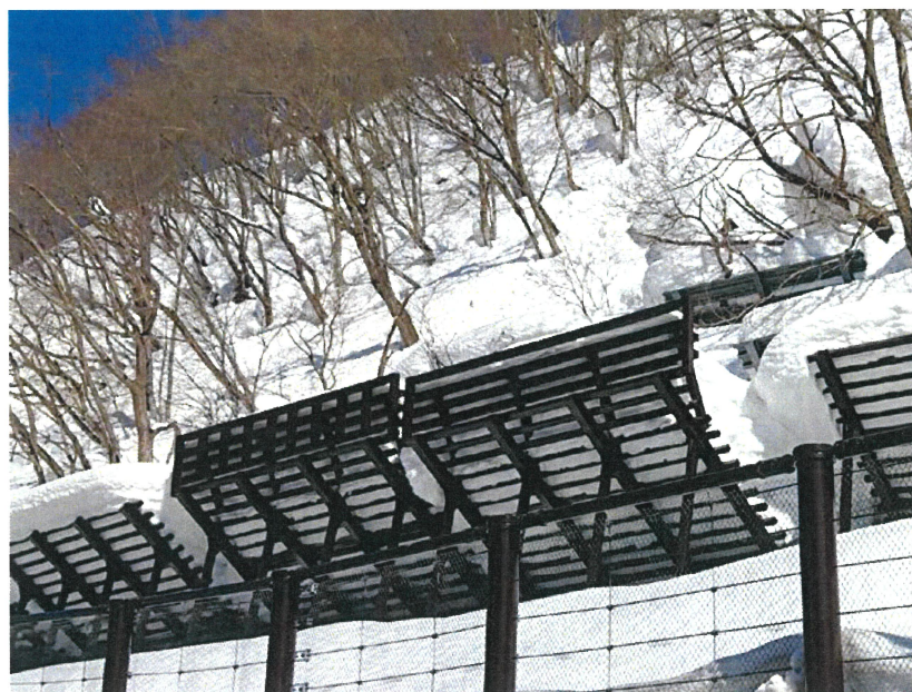
写真 5.2 対策工設置予防柵と未設置予防柵の状況（三俣）
