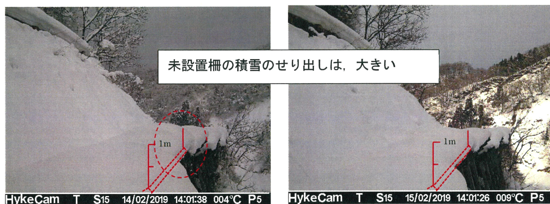
雪底防止工未設置の状況
