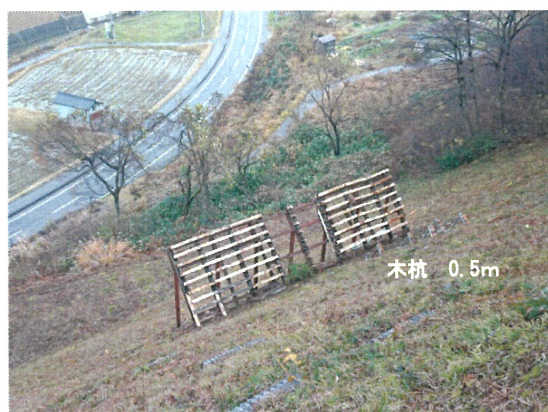
写真 4.3 木杭設置状況（十日町試験地）
