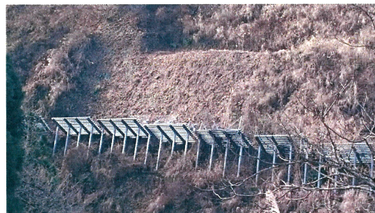
写真 4.1 トライパイル設置状況（小白倉）
